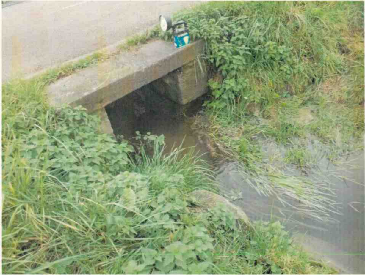
Photo N°2 Vue aval de l'aqueduc
