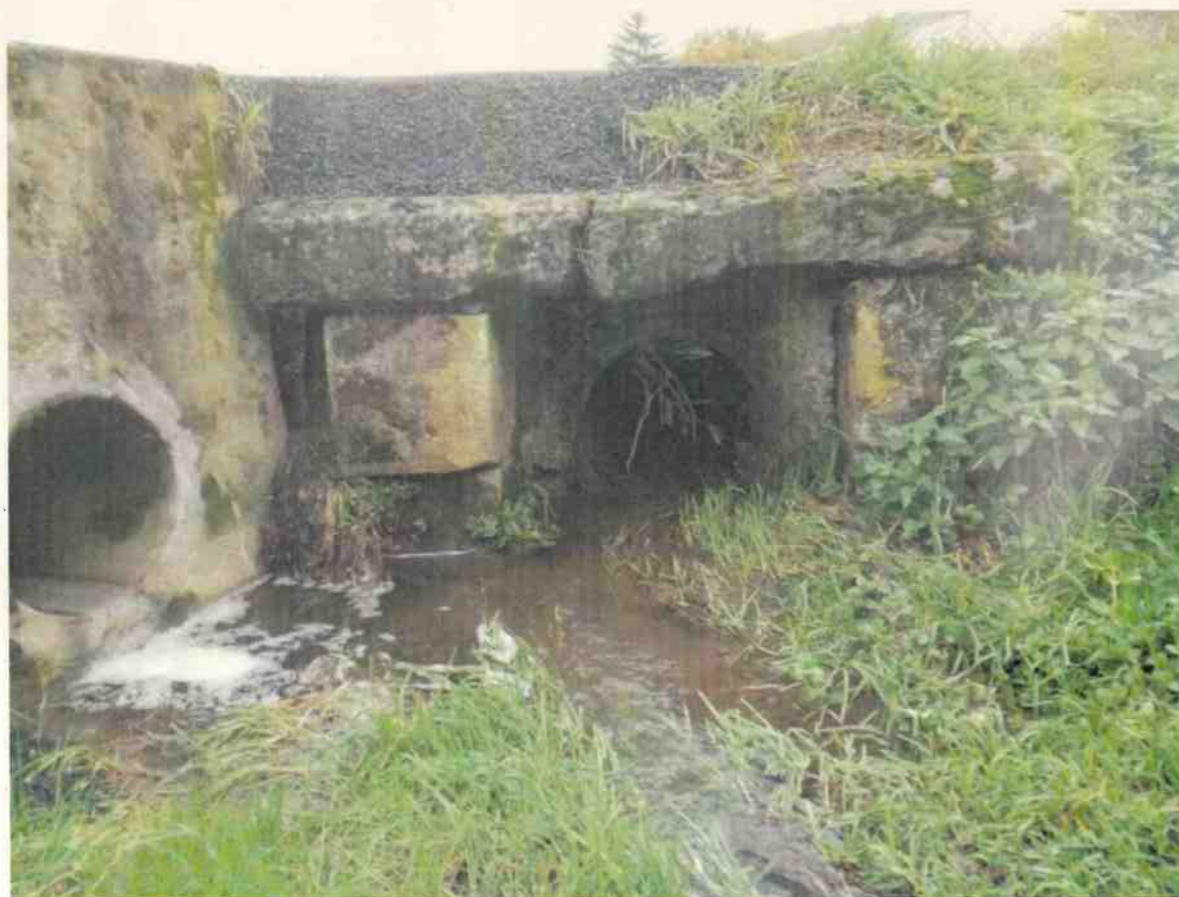
Photo N°1 Vue amont de l'aqueduc
