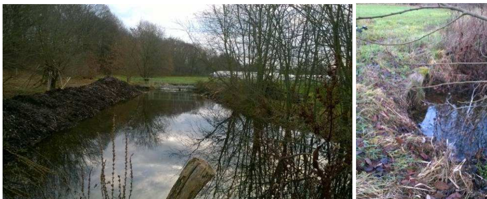
Figure 24 : Vue sur la mare et sur le busage en aval de la mare, photo sinbio 2015
