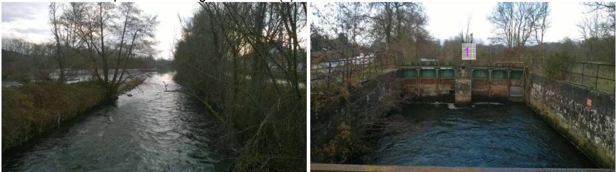
Figure 4 : photos du bief d'amenée commun à R1, R2, R3
