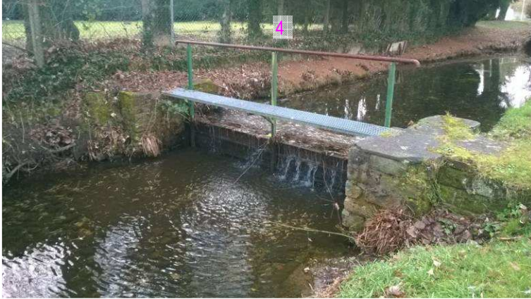
Figure 12 : photo du vannage sur R1
