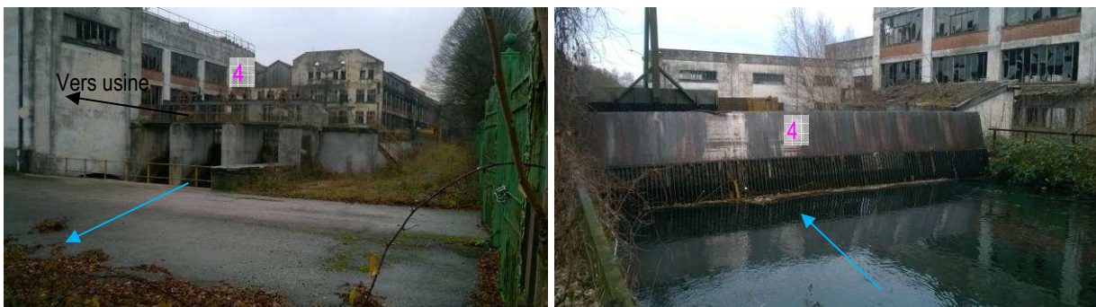
Figure 9 : photos du lit de R1 au droit de l'usine hydroélectrique
