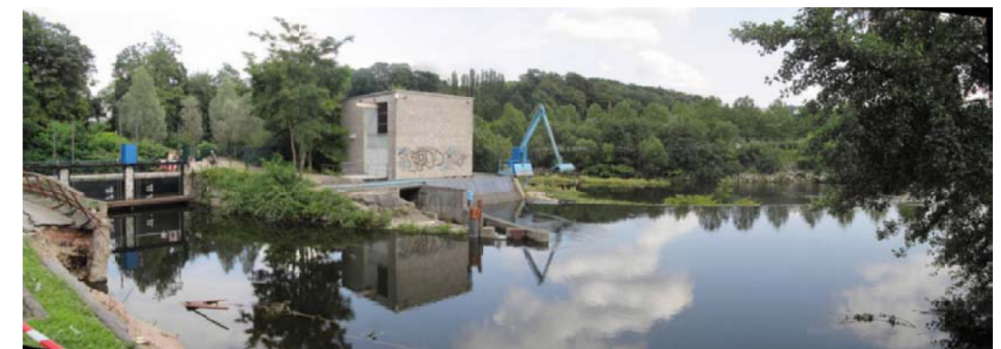
photo 9 : centrale hydroélectrique de La Gosse
