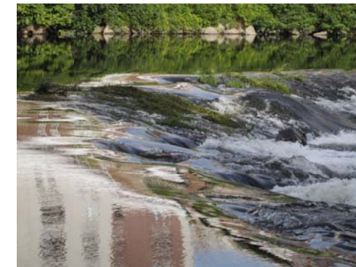
photo 5 : échancrure sur le barrage du Cours
