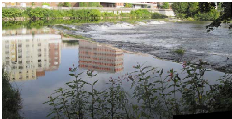
photo 3 : barrage du Cours
