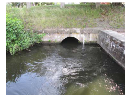
photo 27 : alimentation du canal des Vosges
