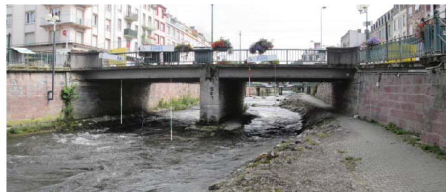
photo 18 : Pont du Boudiou
