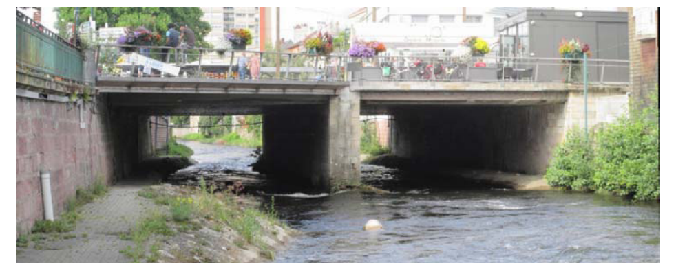
photo 24 : pont des 4 nations
