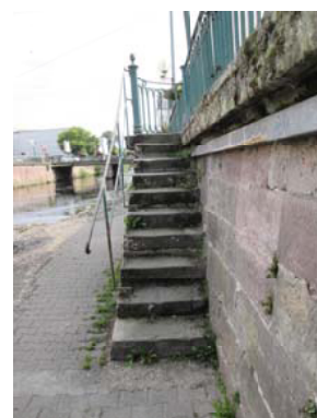
photo 22 : escalier vers les quais
