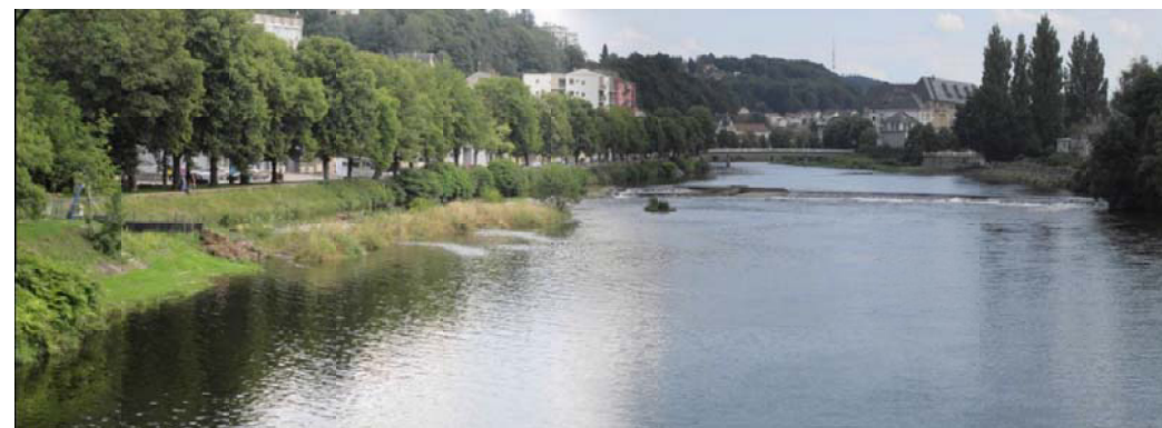
photo 8 : barrage de prise d'eau du canal des Vosges
