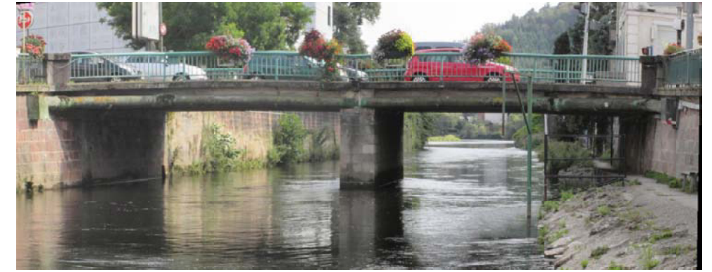
photo 14 : pont de la Xatte - départ du parcours existant
