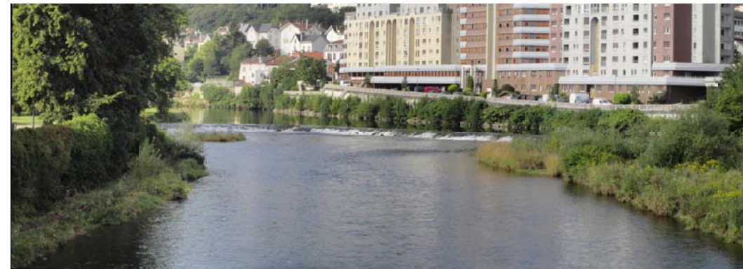
photo 4 : barrage du Cours depuis l'aval
