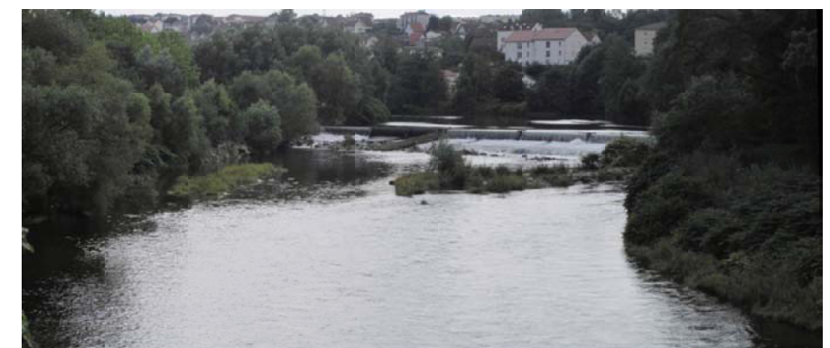
photo 12 : barrage de La Gosse
