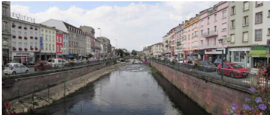
photo 15 : vue amont première partie du parcours existant
