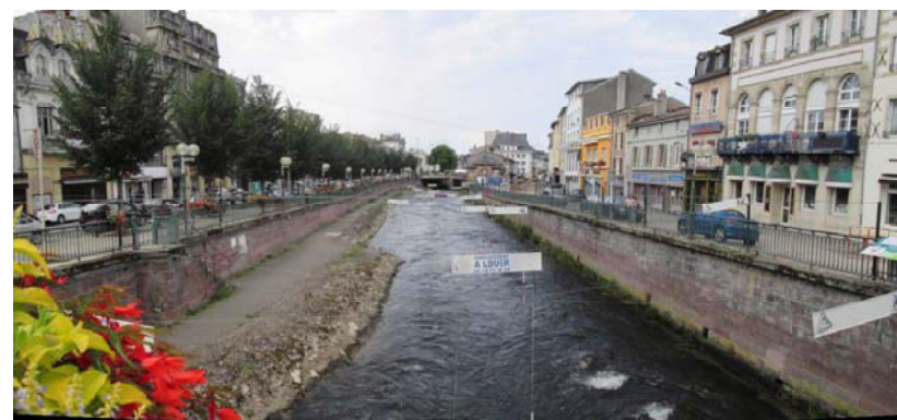
photo 19 : vue amont deuxième partie du parcours
