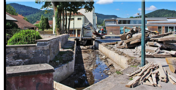
Renaturation du Naufaing sur la Place de la Libération à Vagney
