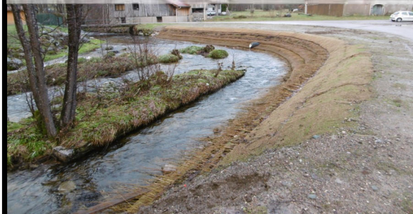
Requalification de berge sur le Bouchot à Rochesson
